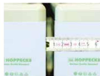
Abb. 5-14: 10 mm Abstand zwischen den Batteriezellen
