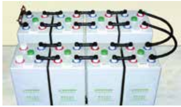
Abb. 5-15: Einsatz von Reihenverbindern und Stufenverbindern
