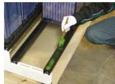
Abb. 5-13: Behandlung der Abstellschienen
