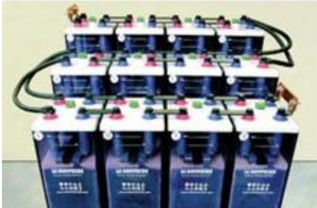
Abbildung 6.6.6-1 - Einsatz von Reihen- und Stufenverbindern
