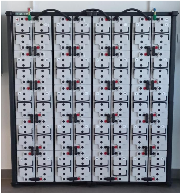
6-3 - Beispiel für horizontale Batterieanordnung
