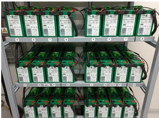
Abbildung 6.6.5-1 - Einsatz von Reihen- und Stufenverbindern
